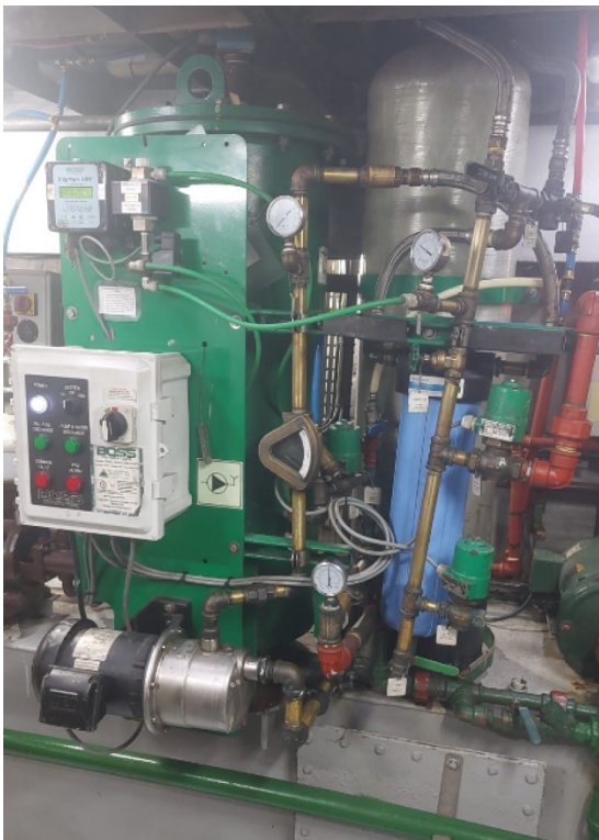
Figura 16 Separador de aguas de sentina
