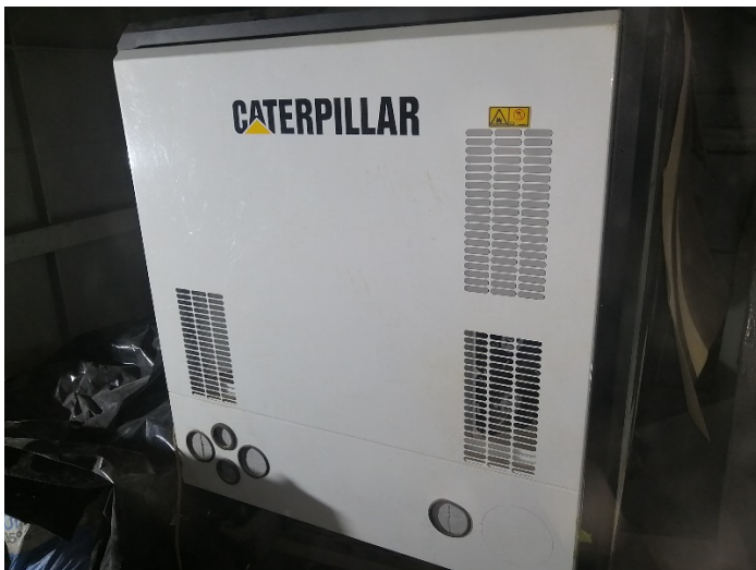
Figura 10 GRUPO ELECTROGENO CATERPILLAR MODELO C4.4 DITA Serie No. JIZ09316
