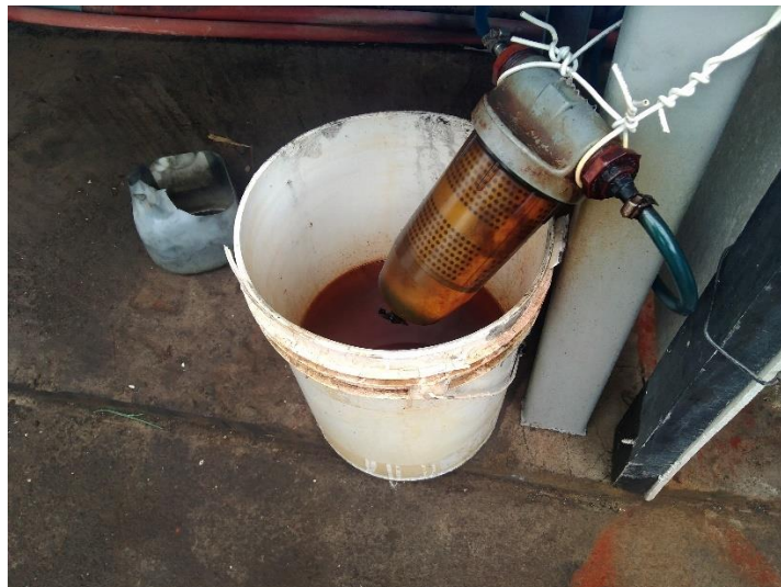
Fotografía 15. Filtros de diésel utilizados en los termostatos del proyecto Fuente: Equipo Técnico
