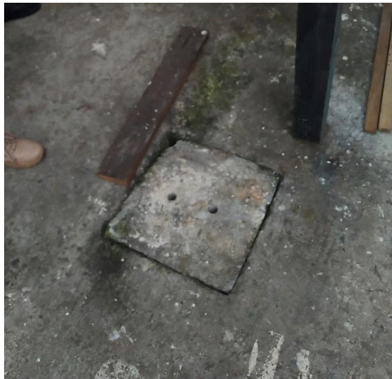
Fotografía 23. Caja de revisión del pozo sellado del edificio Torre Isla Sol
