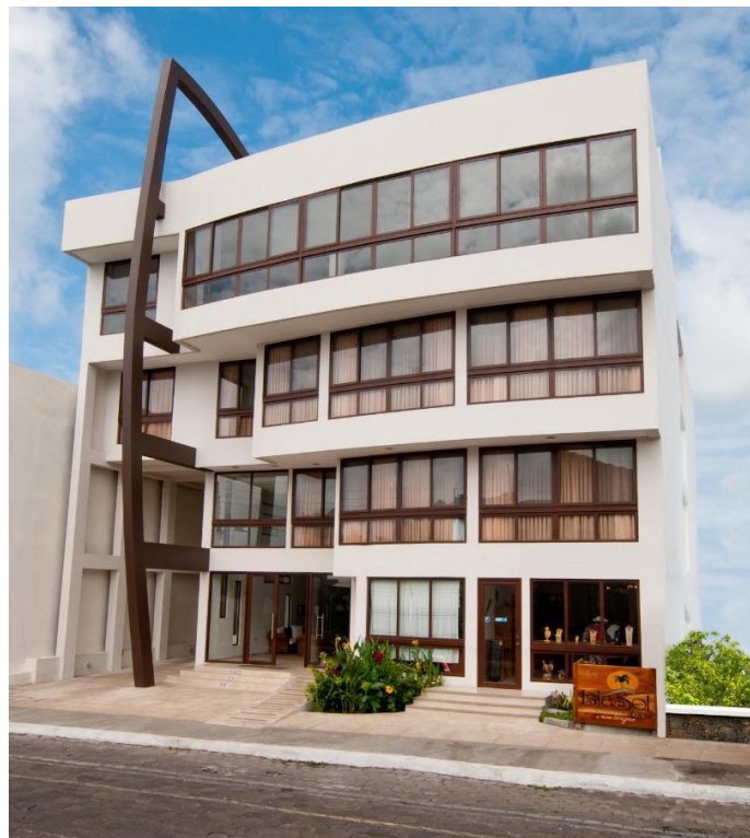
Fotografía 2. Vista de la Torre Isla Sol, complemento del Hotel Solymar
