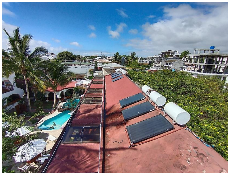
Fotografía 16. Paneles solares ubicados en la torre posterior del hotel Fuente: Trabajo de campo equipo consultor, enero 2023
