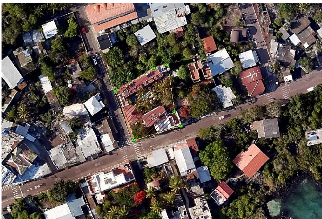
Ilustración 1. Ubicación del proyecto “Hotel Silberstein”, demarcado con líneas rojas se representa el área de implantación del mismo.
