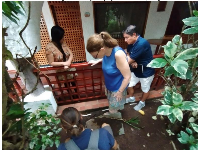
Fotografía 14. Inspección del estado de las cajas de revisión de pozos sépticos
