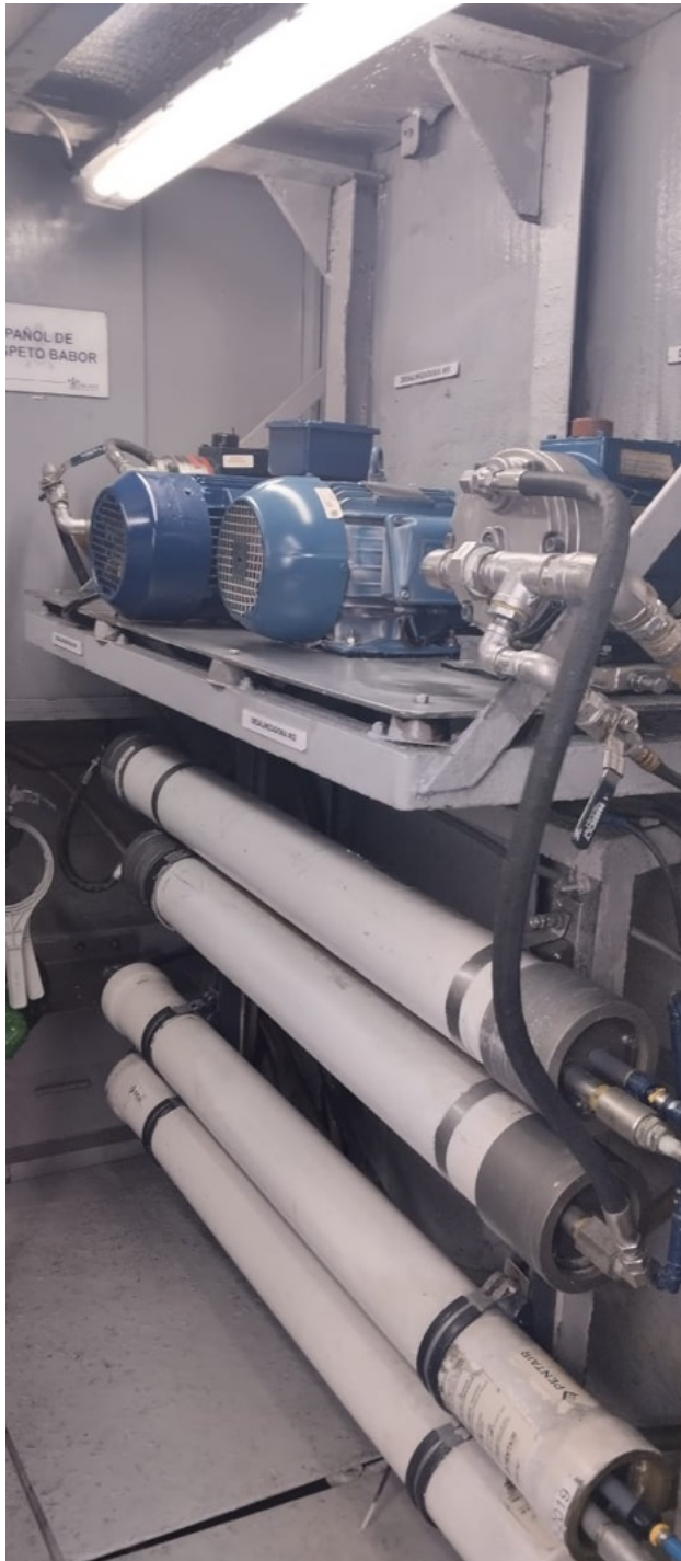
Figura 26 DESALINIZADORA
