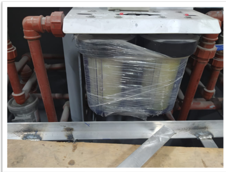
Figura 35 SEPARADOR DE AGUAS DE SENTINA
