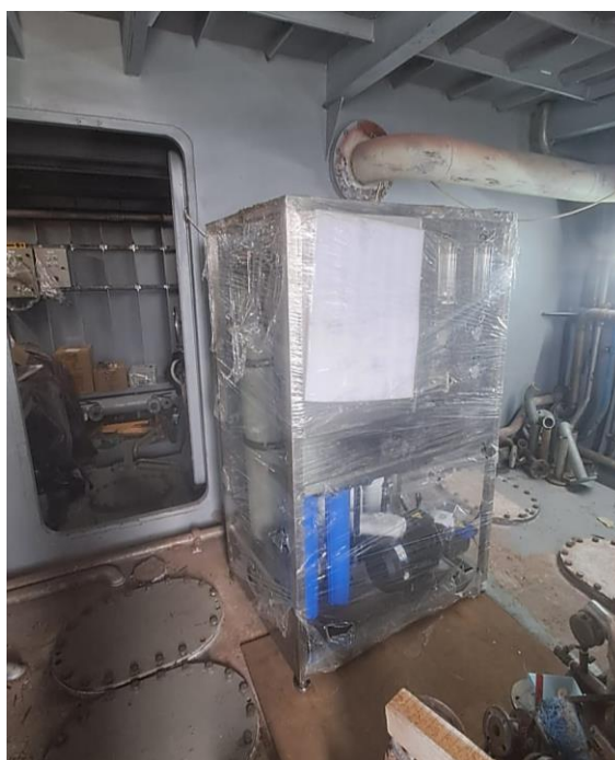
Fotografía 10. Planta desalinizadora lista para instalación a bordo del ANGELITO II
