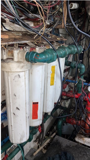
Figura 17 SEPARADOR DE AGUAS DE SENTINA
