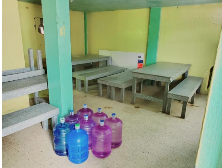
Fotografía 40. Área de comedor en el PAFV Fuente: DIGAS, 2022
