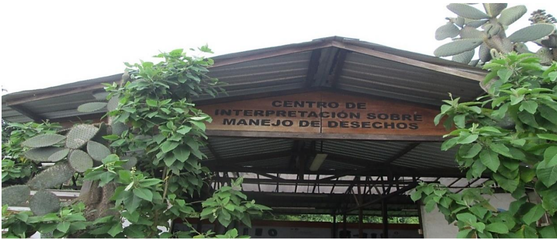
Fotografía 36. Vista externa del área utilizada como Centro de Interpretación
