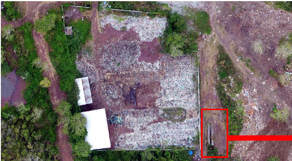
Fotografía 46. Infraestructura actual que será utilizada para el lavado de vehículos del SGIRS
