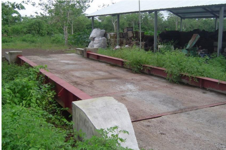
Fotografía 8. Balance de pesaje para camiones recolectores Fuente: Archivo fotográfico DIGAS – SGIRS – GADMSC
