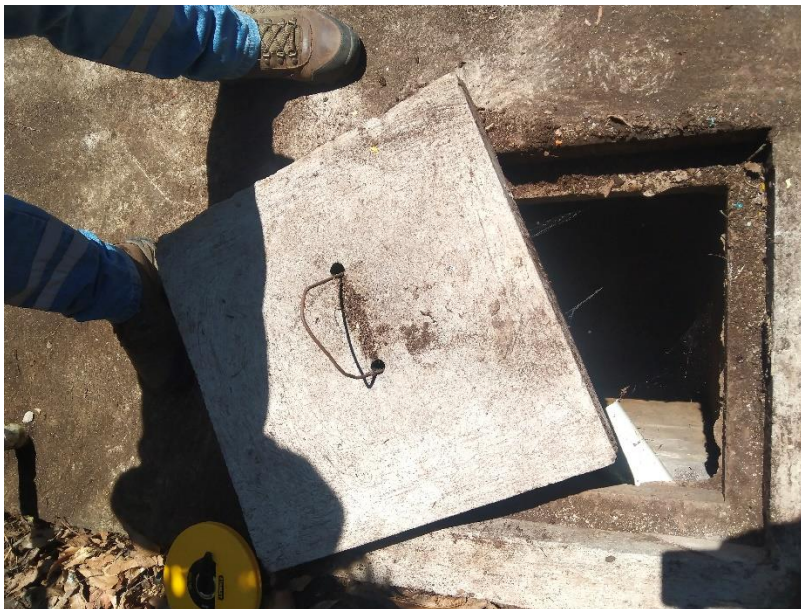
Fotografía 45. Apertura de una caja de revisión del pozo séptico ubicado frente al edificio de la oficina principal
