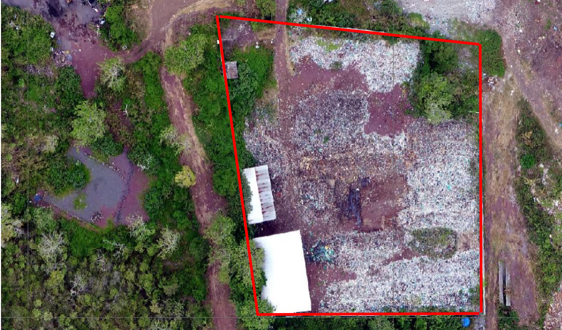
Fotografía 20. Área de compostaje de residuos orgánicos Elaboración: Equipo Consultor, marzo 2021
