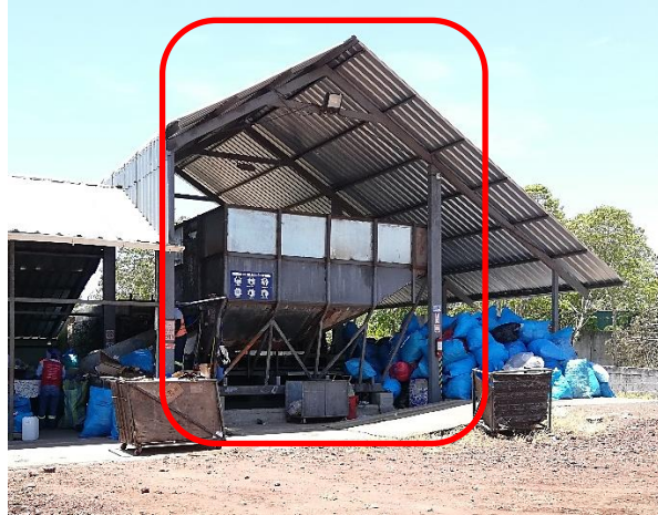
Fotografía 6. Tolva de recepción de materiales
