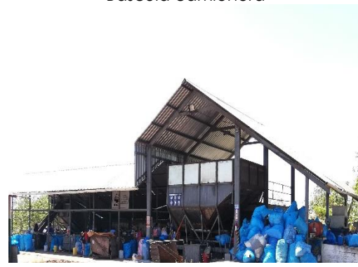
Galpón de separación de materiales
