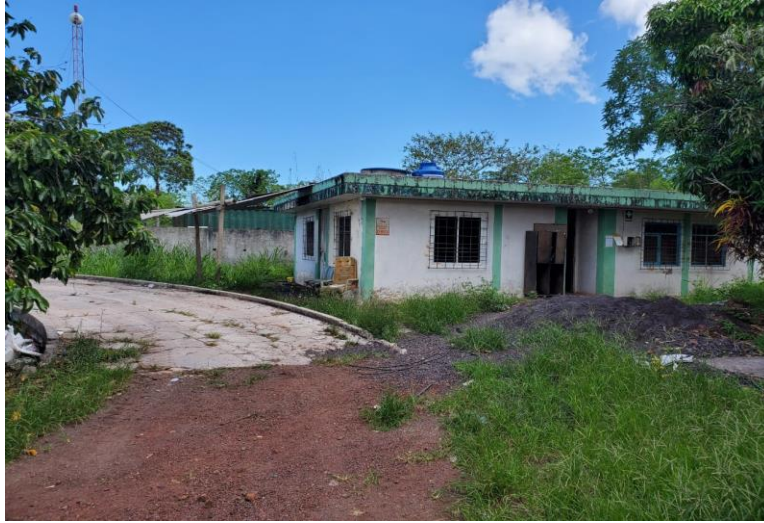
Fotografía 38. Edificación con servicios adicionales para el personal del PAFV Fuente: DIGAS, 2022
