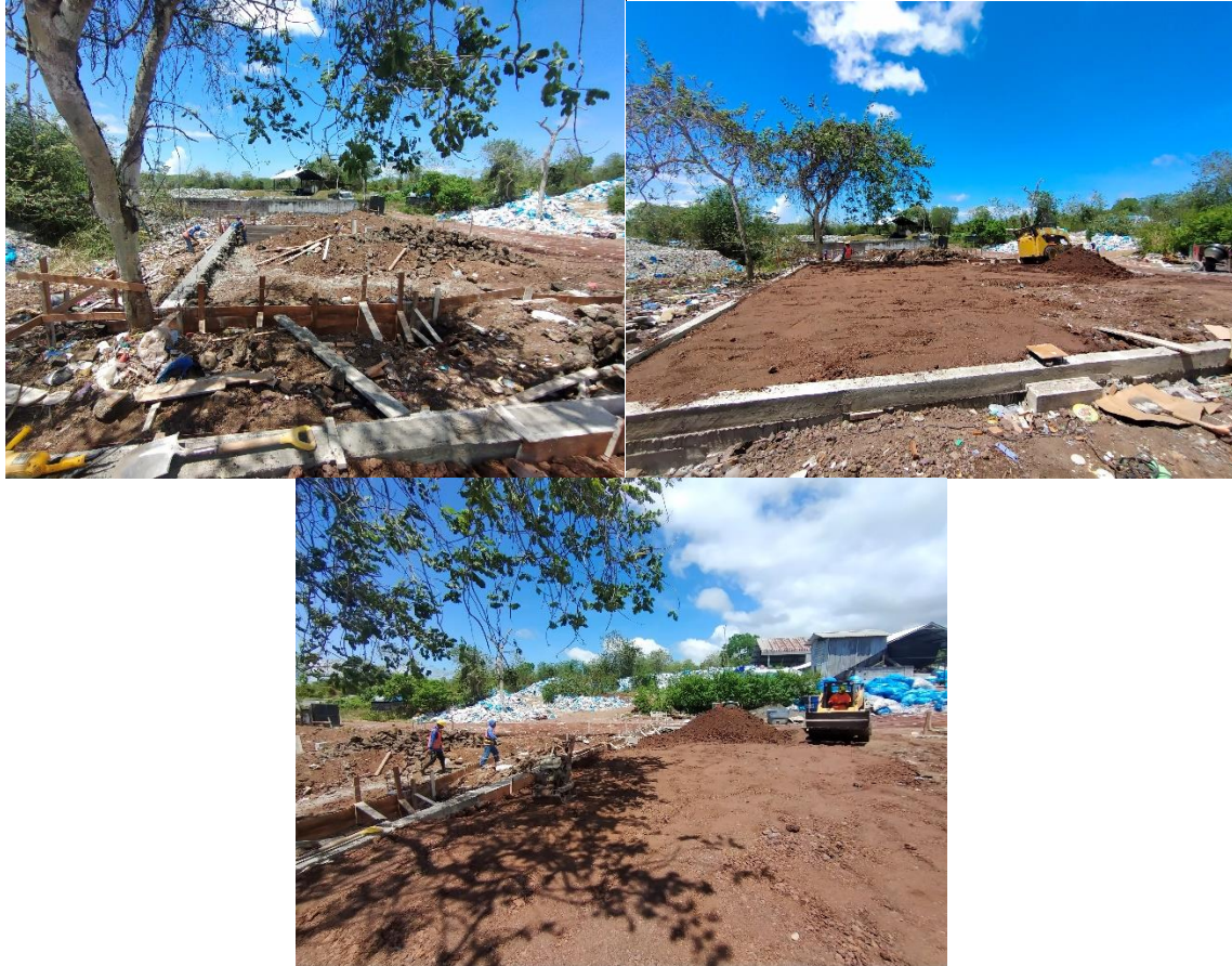
Fotografía 53. Construcción de nuevos galpones, junto al área de compactación de materiales
