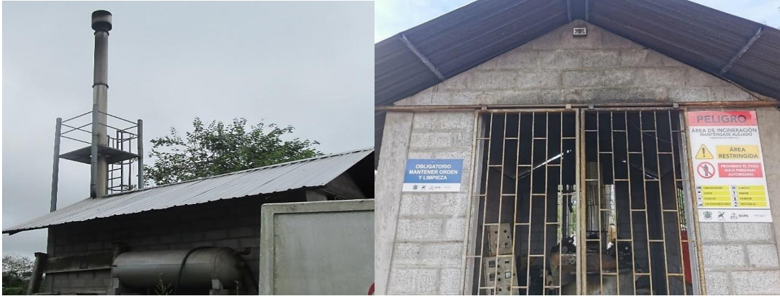
Fotografía 32. Área de tratamiento de desechos sanitarios
