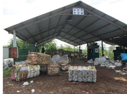
Galpón de compactación
