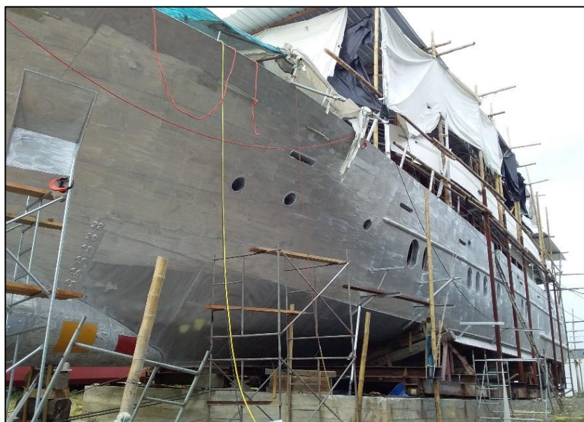
FOT. No. 4: Construcción
