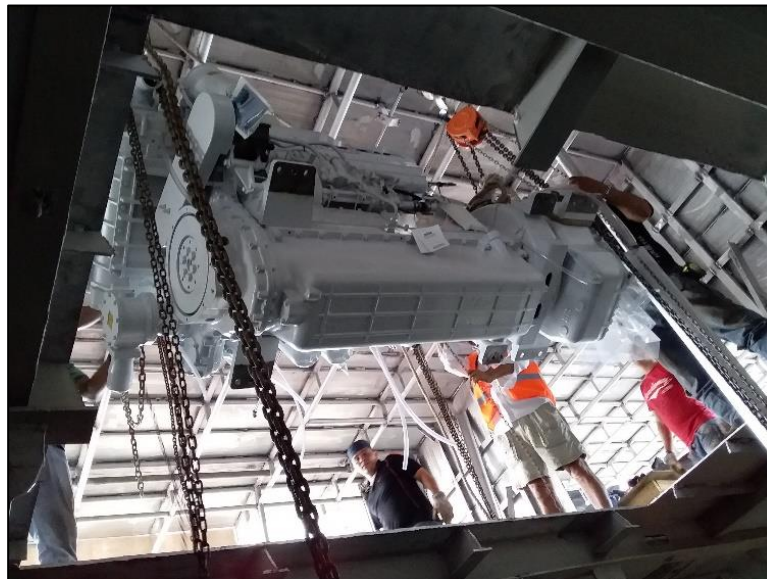
FOT. No. 10: Instalación motores principales Yanmar
