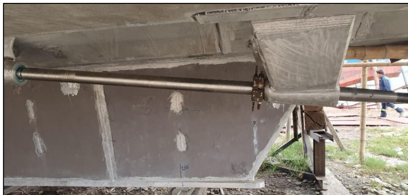
FOT. No. 12: Ejes propulsores
