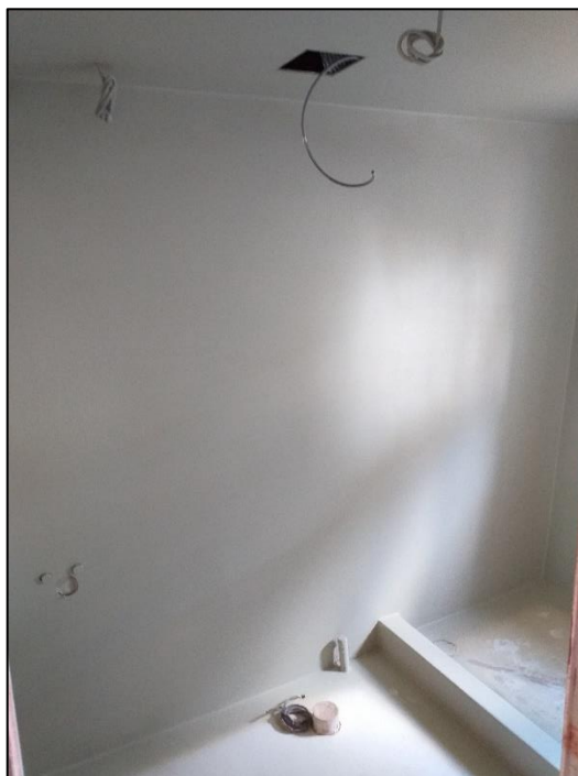
FOT. No. 8: Colocación de fibra de vidrio
